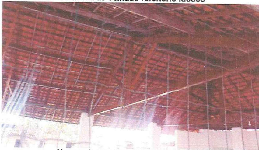
Nova coberta do Refeitório dos Idosos
